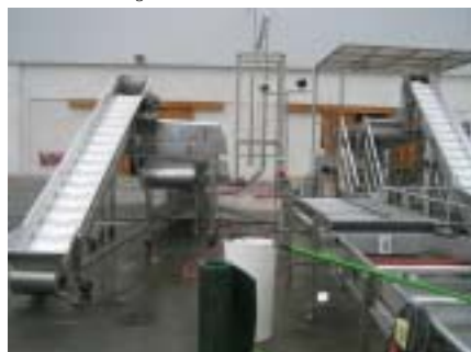
Alimentazione delle uve Convogliatori a nastro elevatore con vaschette
